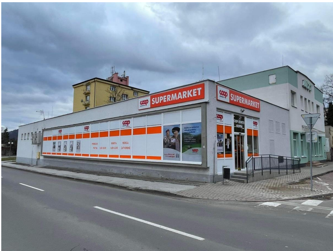
Obrázok 5 – Exteriér predajne SUPERMARKETU s novým bezbariérovým vstupom
